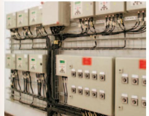
Steuerung und Überwachung von bis zu 130 Heizkreisen je Überwachungseinheit
